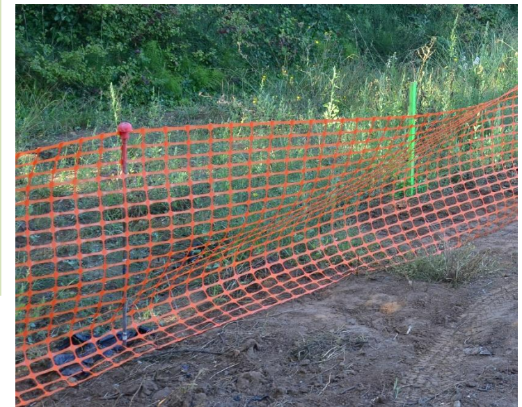
☞ Photographie 23 : Dispositif de limitation des emprises des travaux
