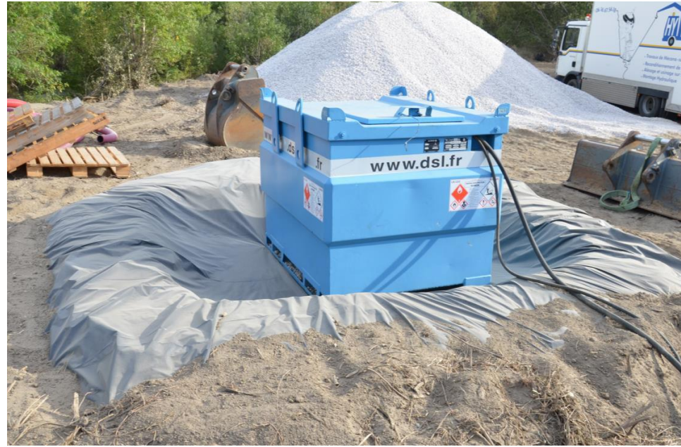
☞ Photographie 24 : Mise en place d'une aire étanche autour d'un groupe électrogène
