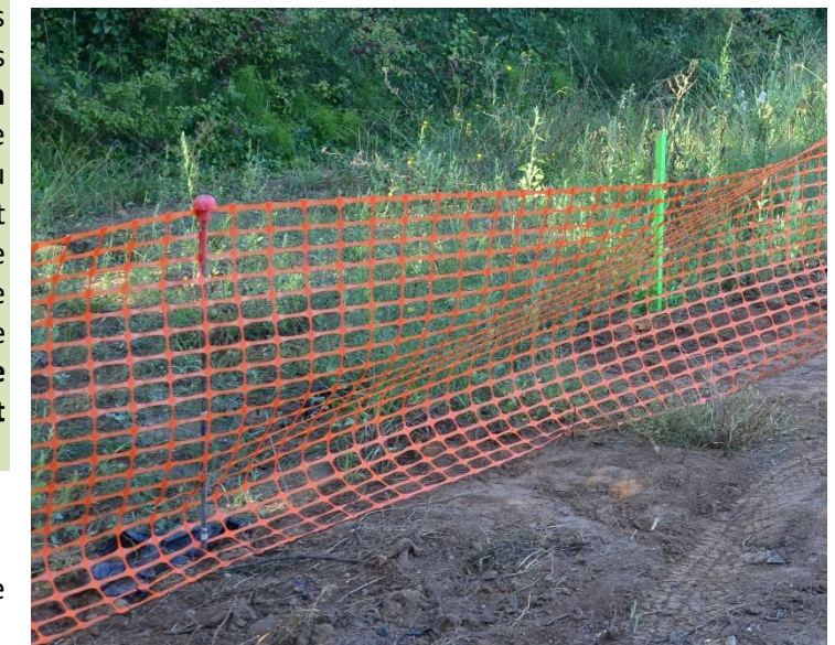
☞ Dispositif de limitation des emprises des travaux
