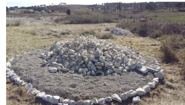
Recouvrement par des blocs de 100-200 Ø mm
