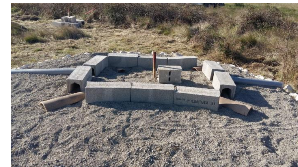
Mise en place du radier en graves concassées, des éléments constitutifs du gîte
