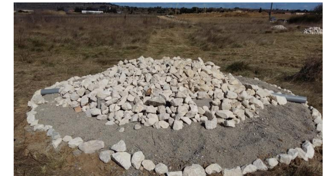
Recouvrement par des blocs de 100-200 Ø mm
